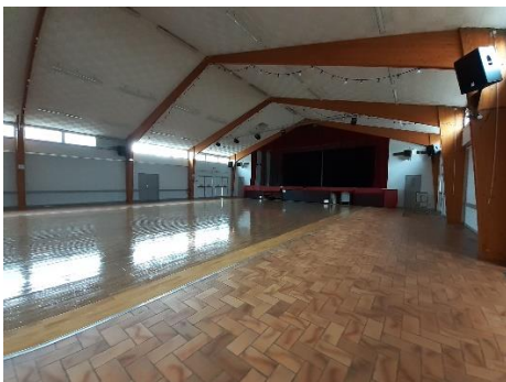
Isolation de la salle des fêtes d'Ouzouer-le-Marché à Beauce-la-Romaine Coût (isolation) : 198 00 € HT - Subvention CRST : 99 000 €
