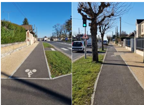
Création d'une piste cyclable à Meung-sur-Loire Coût : 346 000€ HT - Subvention CRST : 178 200 €
